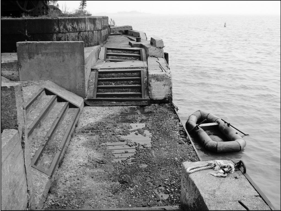
Причал северного форта №6
