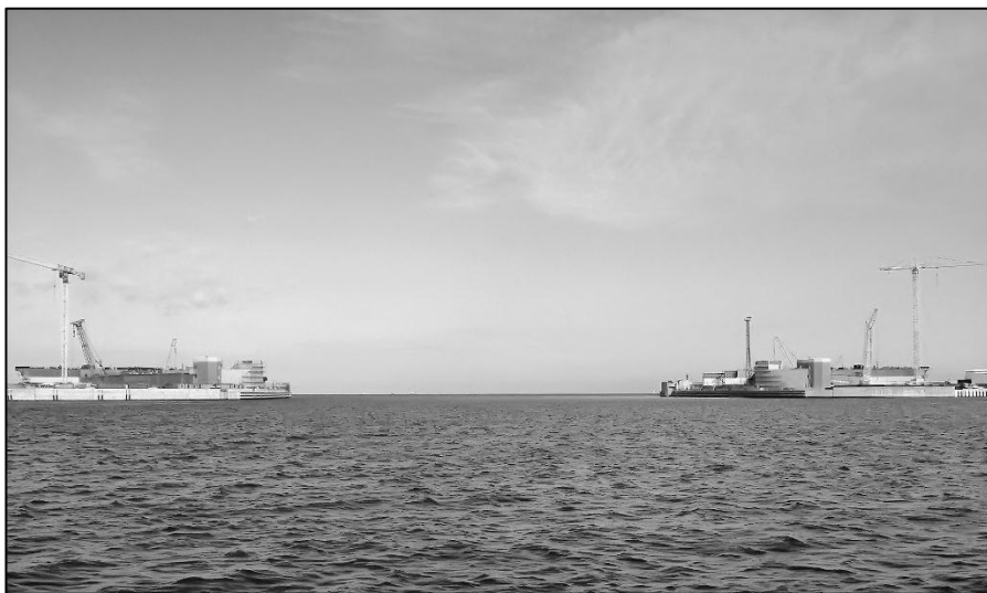
Судопропускное сооружение «С-1»
