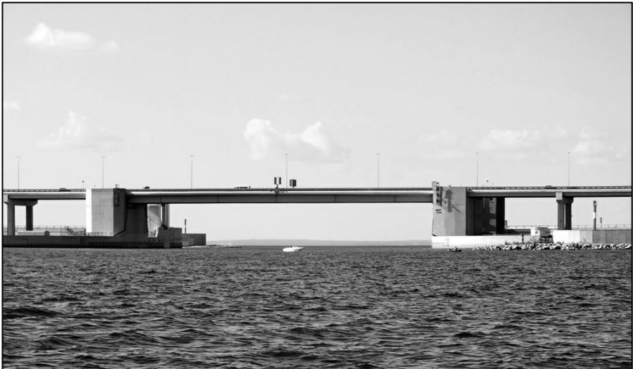
Судопропускное сооружение «С-2»
