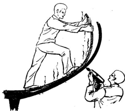
Рис. 262. Установка гнутых шпангоутов в распаренном состоянии.
