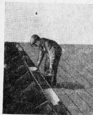
Рис. 90. Нанесение клея на доски при склеивании копаней.
