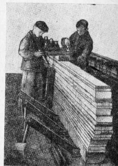
Рис. 91. Сборка пакетов копаней.
