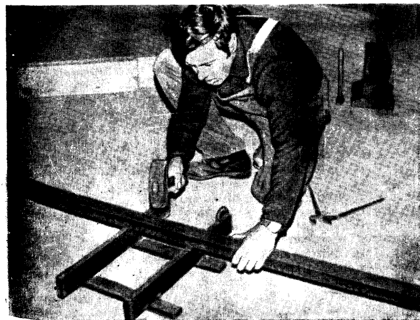
Рис. 85. Гибка профиля с помощью кувалды.
