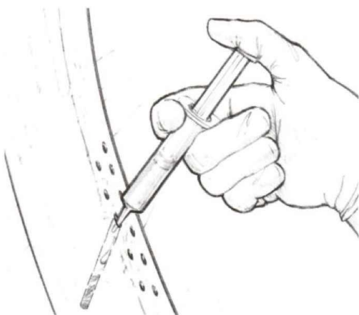
Рисунок 3-4 Введите смесь смолы с отвердителем в отверстия, пока повреждённая древесина не впитает максимальное её количество.
